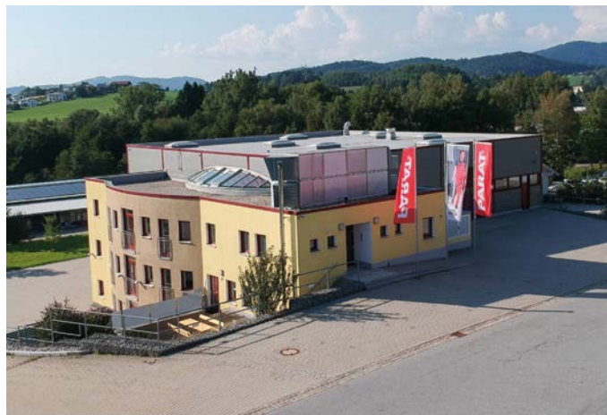
Mehr Platz für Innovation: 2023 bezieht Parat den neuen Standort in Waldkirchen. (Fotos: Parat Solutions GmbH)
