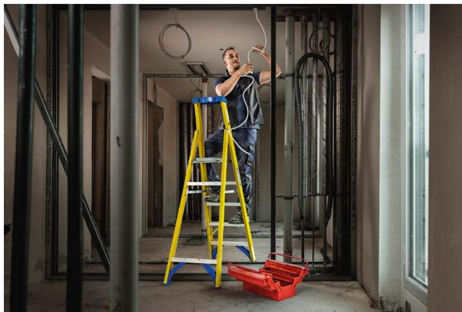
**Mit der GFK-Stufenstehtleiter von Werner ist dank nichtleitender Glasfaserholme sicheres Arbeiten in der Nähe von Strom möglich. (Fotos: Werner)**
