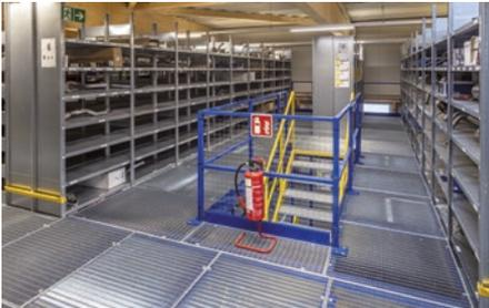
Die Laufflächen wurden aus Brandschutzgründen und für einen beschleunigten Rauchabzug mit Gitterrosten ausgestattet.
