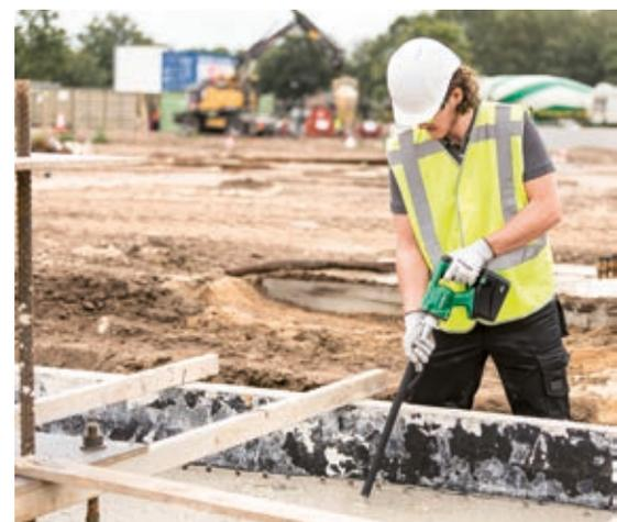
Der kabellose Betonrüttler UV3628DA von HIKOKI läuft bis zu 60 Minuten mit einer Akkuladung. (Foto: Hikoki)
