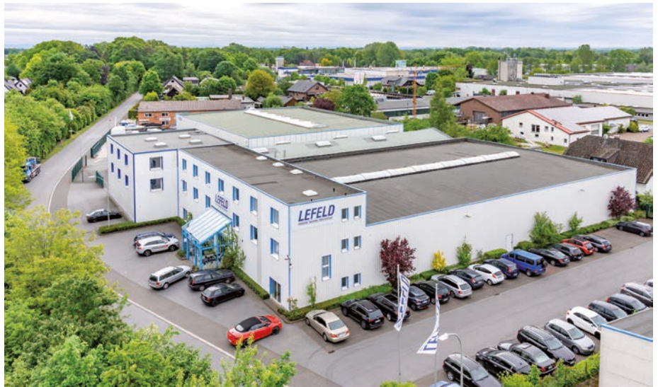
Logistikzentrum der Johannes Lefeld GmbH & Co.KG in Rietberg. (Foto: Johannes Lefeld GmbH & Co.KG)
