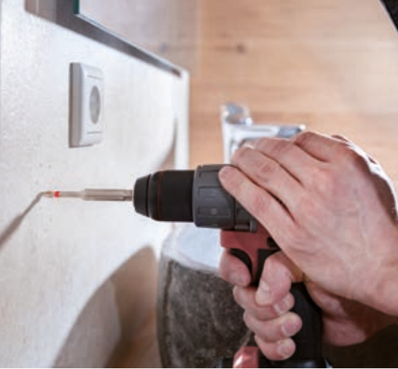
Eine neue Hartmetall-Plattengeometrie sorgt beim C Protector für perfekte Bohrlöcher in der Fliese. (Foto: Alpen)
