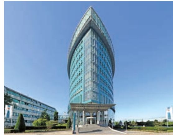
Das EDE-Verwaltungsgebäude in Wuppertal. (Foto: EDE)
